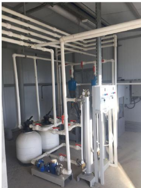
Комплекс очистных сооружений производительностью 200 м 3 /сутки п. Түлкібас, ЮКО
